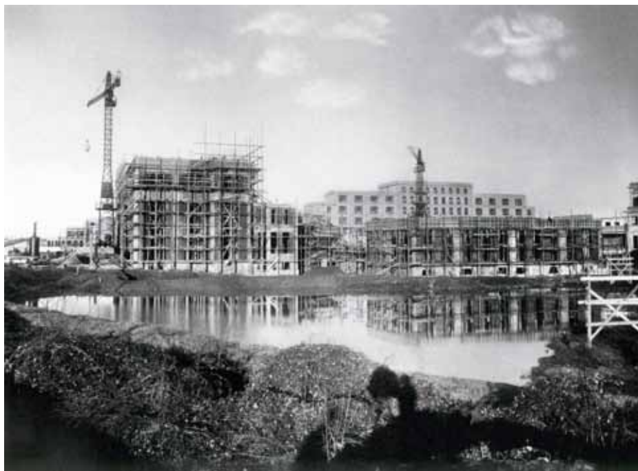
Foto 1 - Il cantiere del nuovo ospedale in una fotografia degli anni trenta dello Studio Fotografico Farabola (Archivio dell'Ospedale Maggiore di Milano, Fototeca, n.669)
